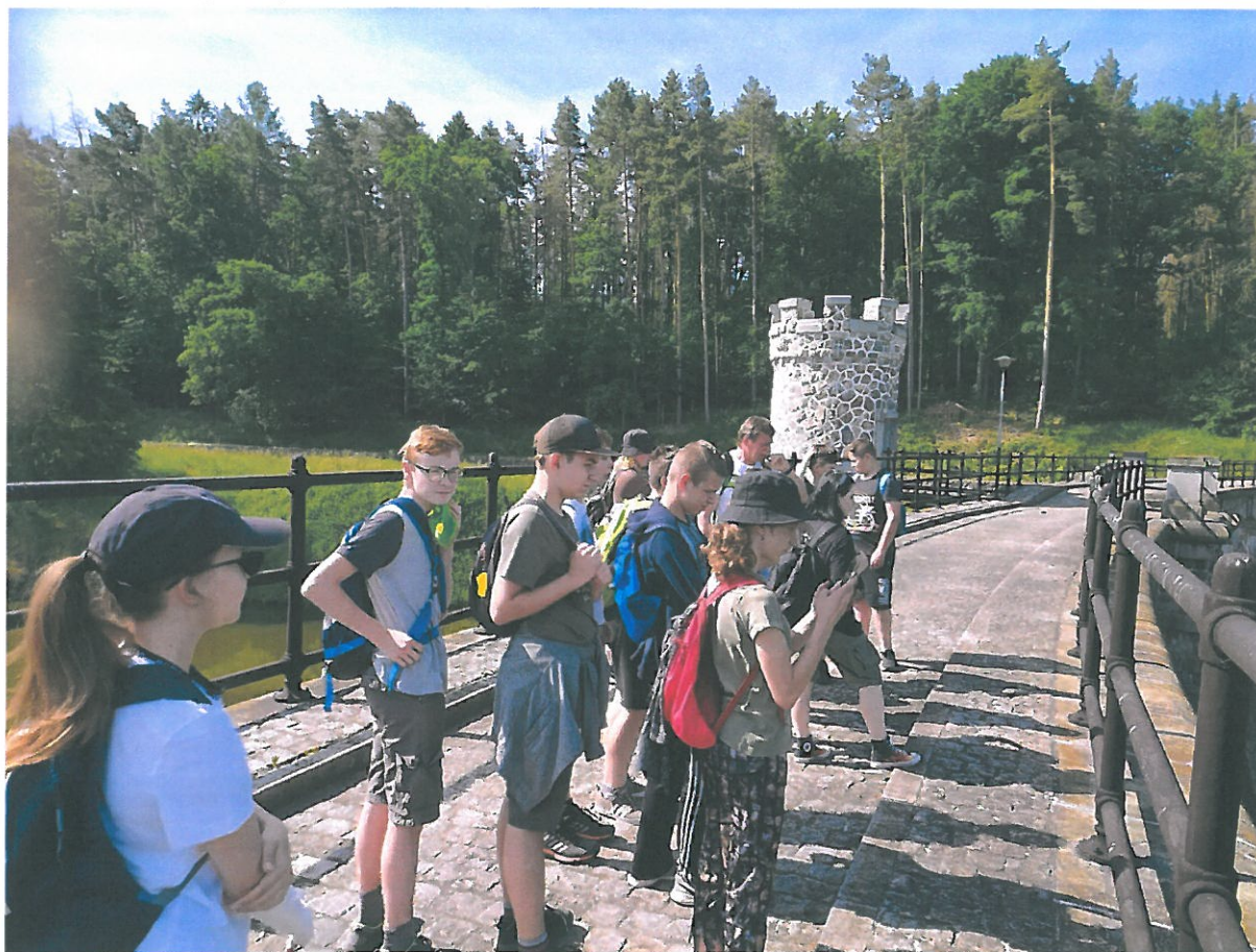
Zeměpisná vycházka Pařížovská přehrada
